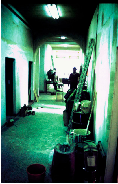
Abb. 37 ▲ Baustelle während des laufenden Betriebs in der Kinderklinik des St.-Barbara-Krankenhauses Halle/Saale (1984). (© Ernst Fukala, mit freundl. Genehmigung)
